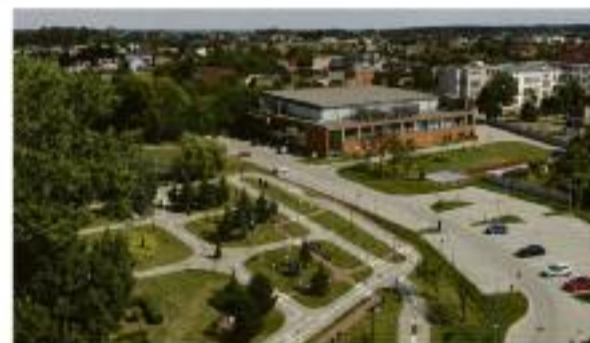
Hala widowiskowo - sportowa
